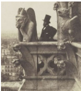
Restauration par Viollet-le-Duc
